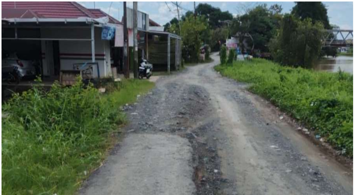
Gambar 2. Perkuatan badan jalan
