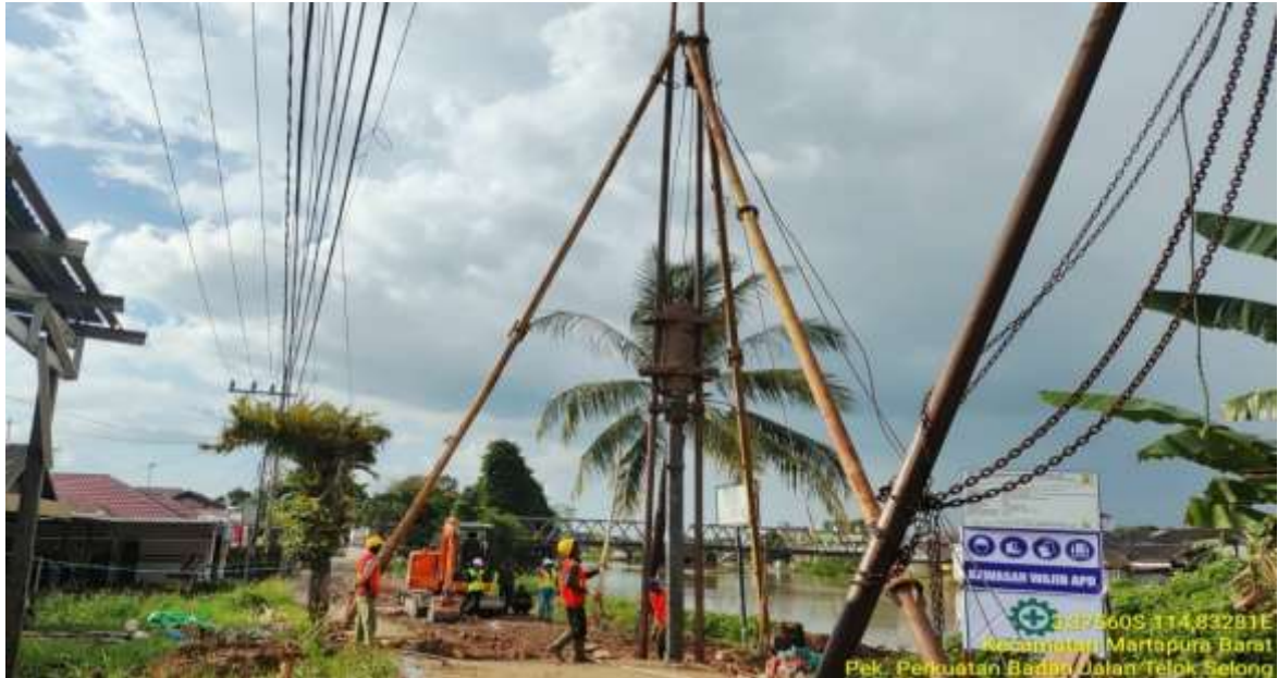
Gambar 4. Proses Pemancangan
